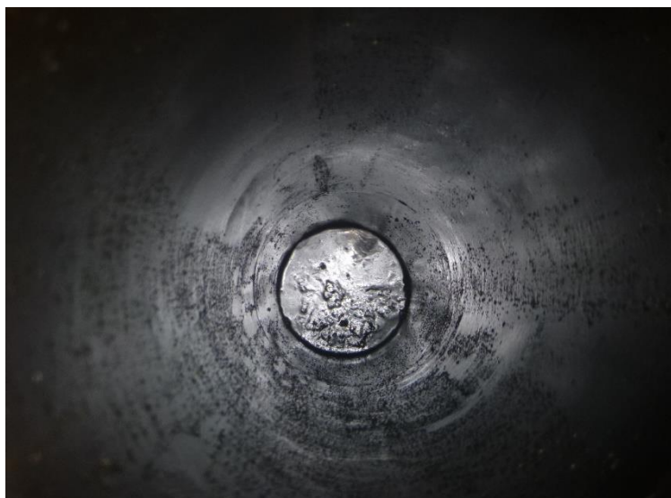
Figure 8 : Photographie de la surface de l'eau à partir du sol au droit de PZ2
