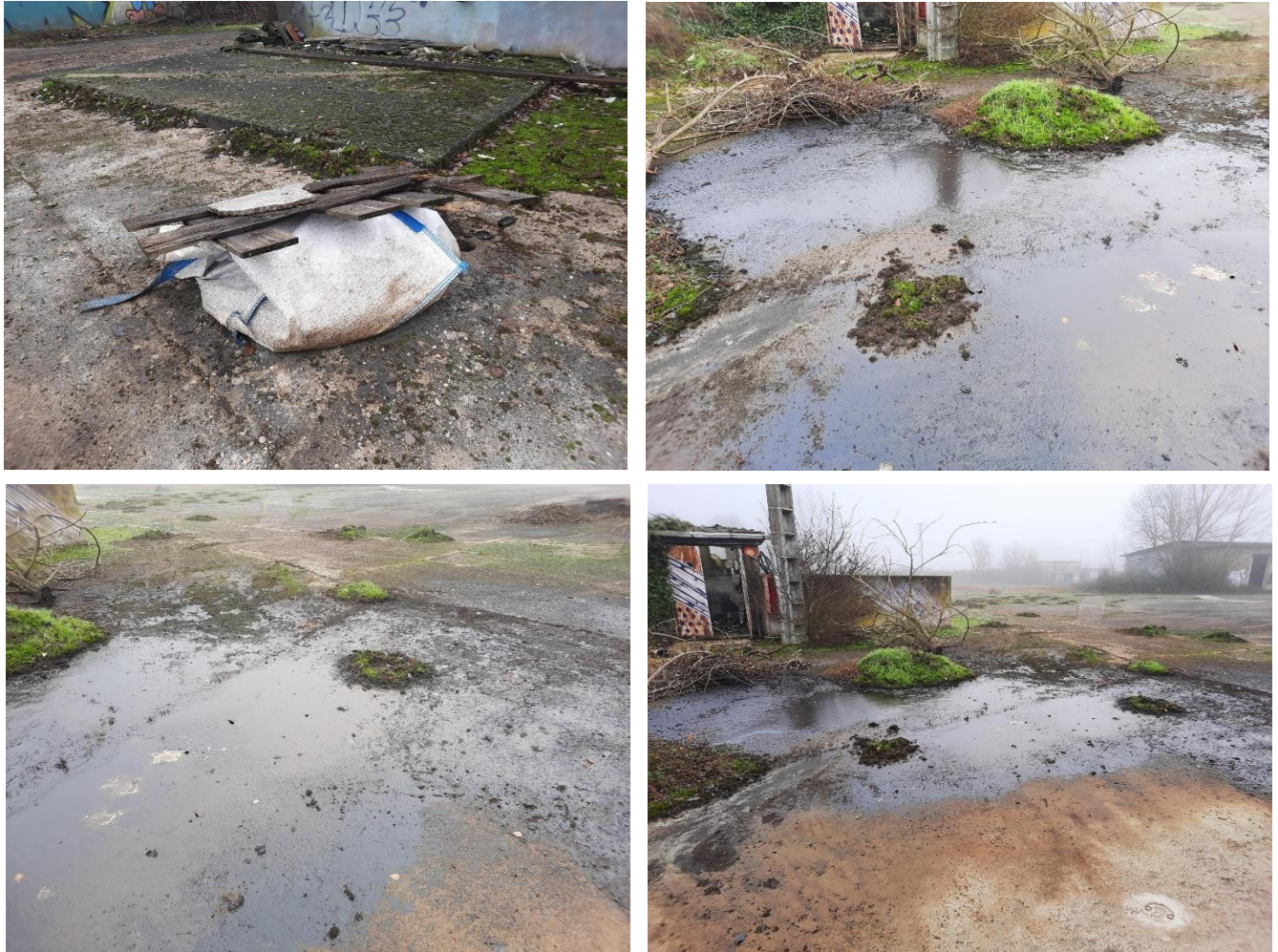
Figure 10 : Photographie de la zone d'écoulement d'eaux hydrocarbonées aux abords de PZ2 (18/12/23)
